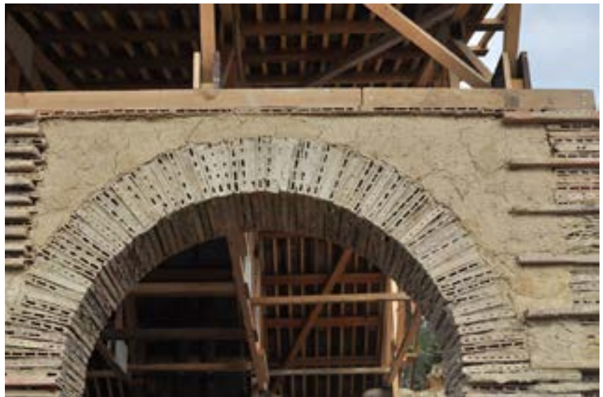
Figure 8 : Détail du pavillon en réemploi, mas de Mirabeau, Fabrègues (34), 2018.
