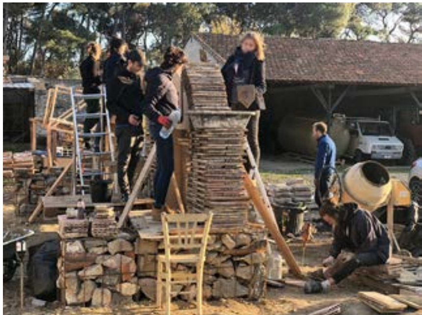
Figure 7 : Construction d'un pavillon en réemploi au mas de Mirabeau, Fabrègues (34), 2019.
